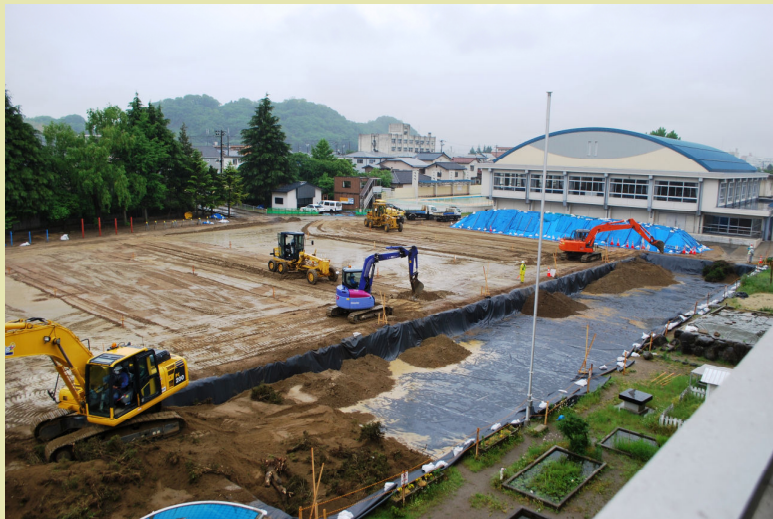
埋設孔に入れられるすきとられた表土
